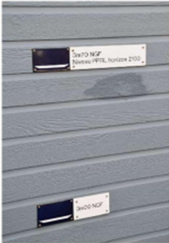
Pose de repères de niveau d'eau avec l'aléa 2010 de submersion, Port de Miquelon.
